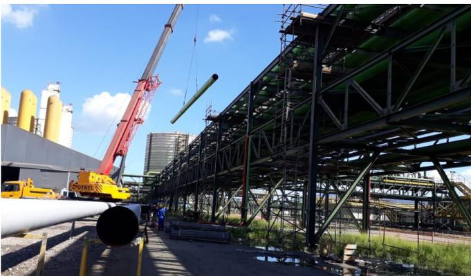
Em novembro concluímos o projeto B189 - Redução de Temperatura CW2 para as Plantas do RH1&RH2, onde implantamos uma unidade para resfriamento da água CW2, por meio de um sistema de troca térmica, para atendimento à geração de vácuo profundo das unidades de refino secundário de aço no RH1 & RH2 na Aciaria de forma a garantir a disponibilidade das unidades de refino para produção de aços especiais durante os períodos mais quentes do ano.
